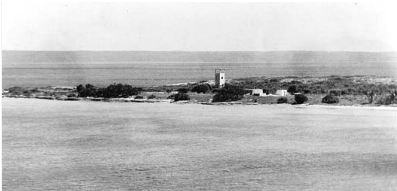
Foto aérea del extremo del litoral occidental de la isla Beata. Esta es la parte más cercana a la península de Barahona, de la que está separada por el canal de la Beata. La torre y los edificios que la rodean son las antiguas facilidades de la estación naval ya abandonada.
