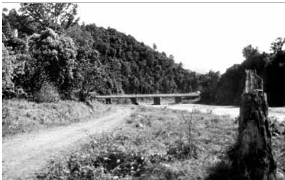
(Foto sup.) Puente sobre el río Nizao, en Las Avispas, donde el camino y el río parecen confluir.
